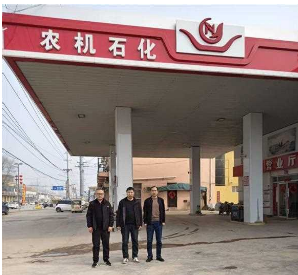
鄆城县旧城农机加油站现场照片
