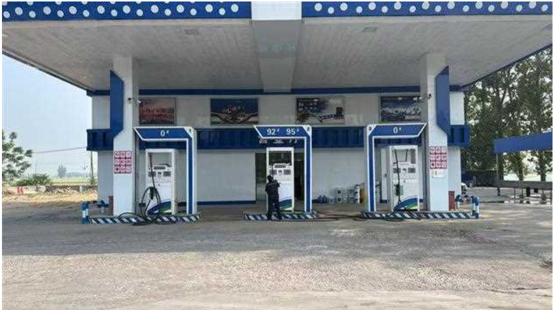
菏泽市牡丹区孙化屯小学加油站现场照片
