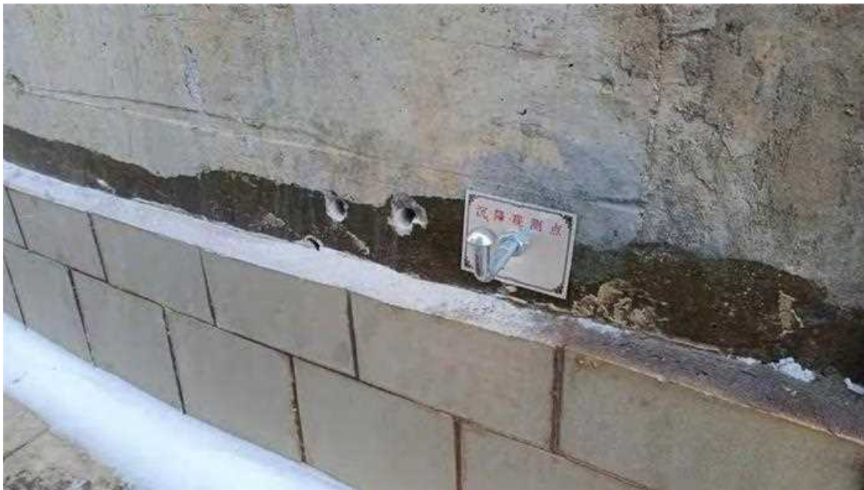
硫酸罐区硫酸储罐已设沉降观测点
