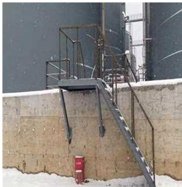
硫酸罐区围堰已在不同方位设置人行踏步
