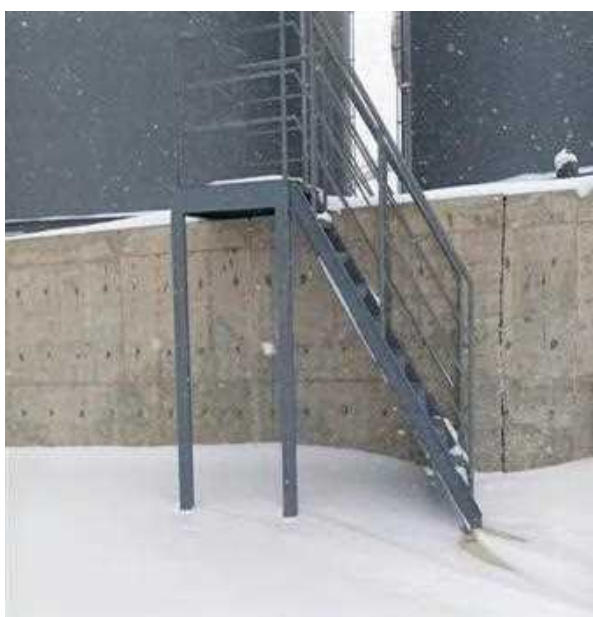
硫酸罐区围堰已在不同方位设置人行踏步
